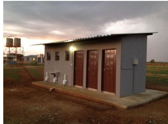
Toiletgebouw met aan de voorzijde en achterkant 3 toiletten met wasbakken
